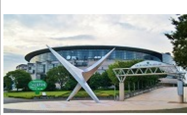
グリーンドーム前橋
